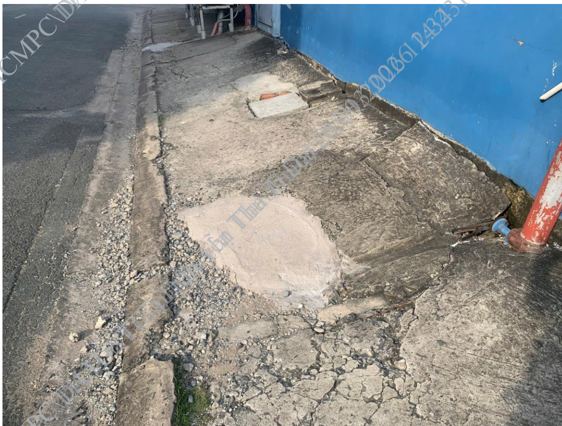
Hình 5: Vĩa hè, hệ thống thoát nước sụp lún
