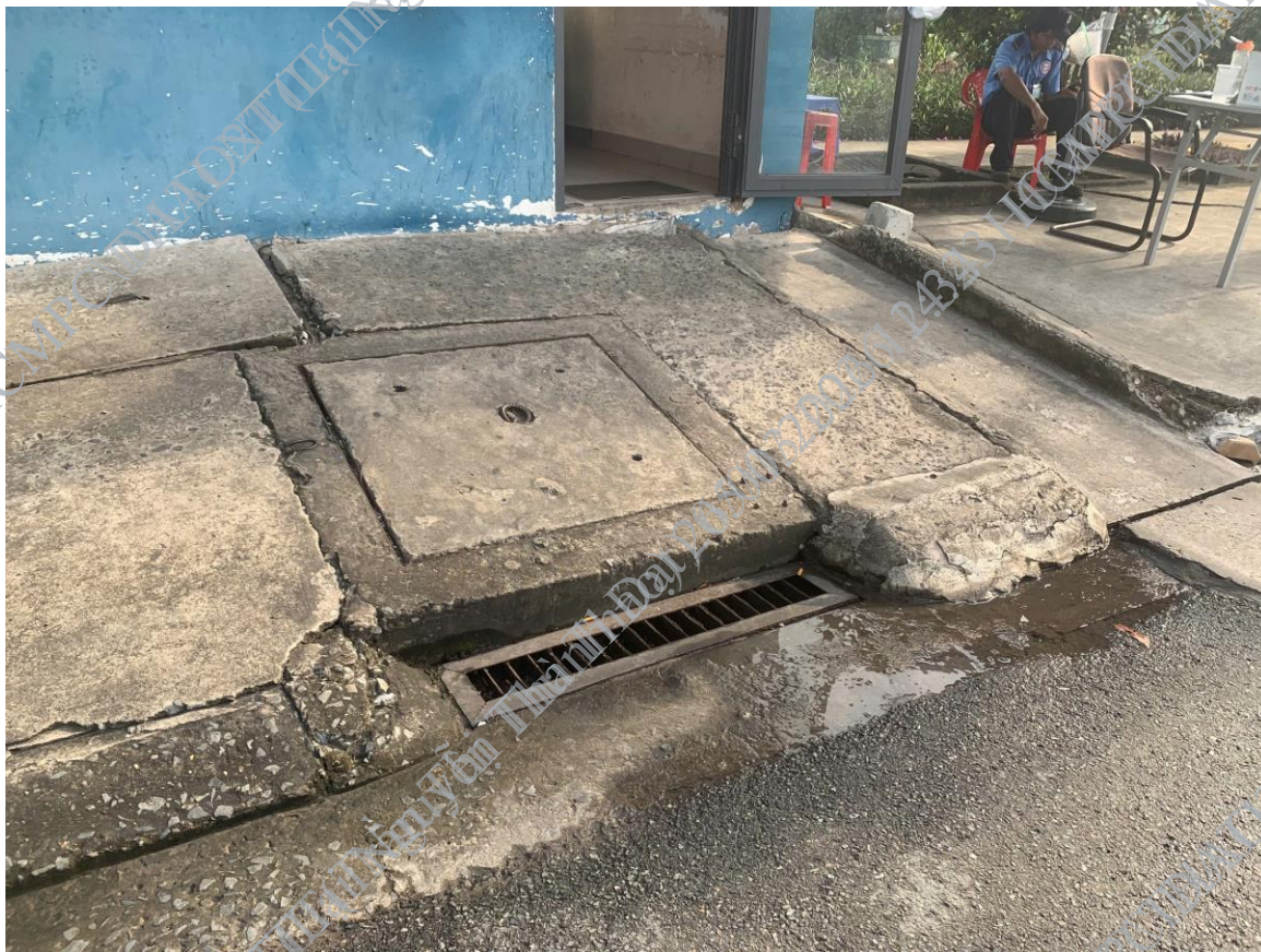
Hình 4: Hệ thống thoát nước sụp lún
